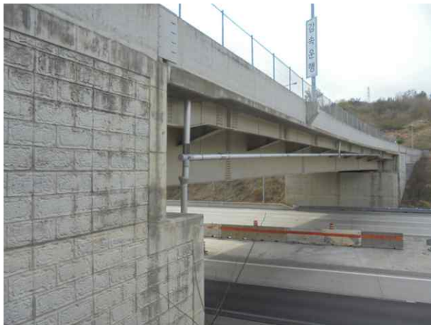
5공구 군위JCT R-A4교 (5공구)
