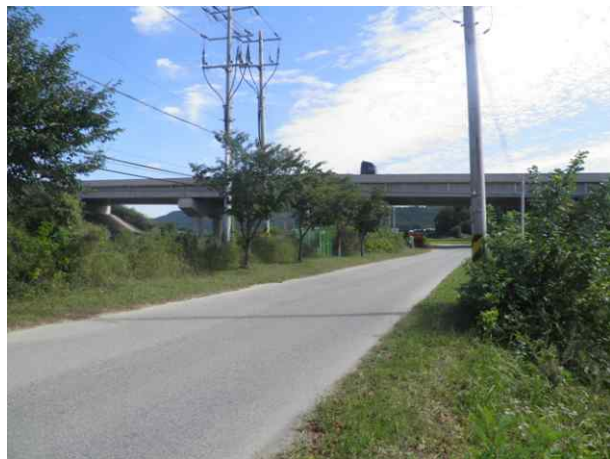
2공구 월가교 (2공구)
