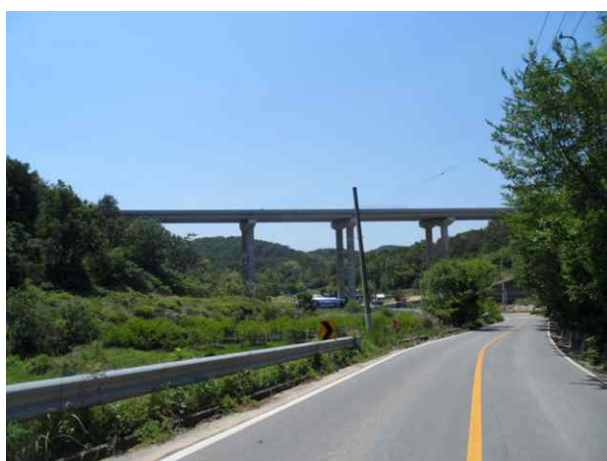
5공구 오실교 (5공구)
