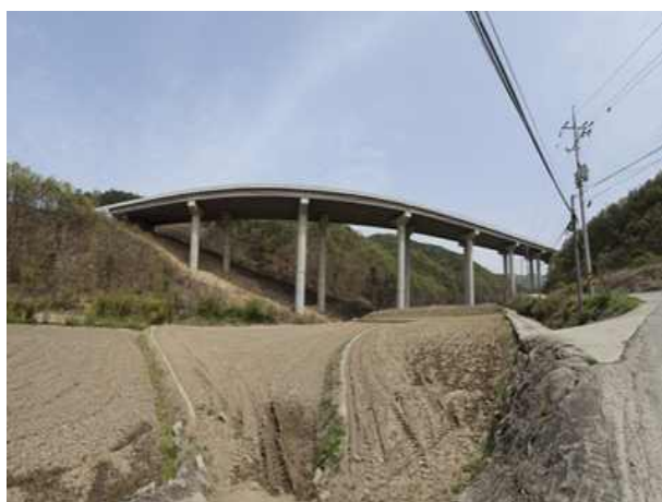
4공구 산호교 (4공구)
