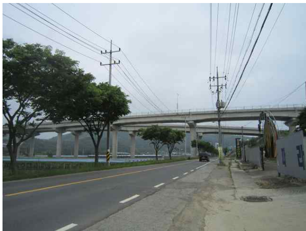
10공구 영천JCT Ramp-A교(10공구)
