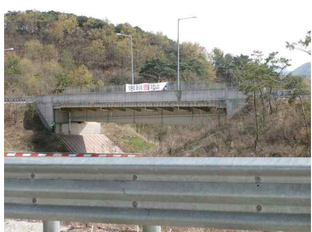
8공구 화산JCT RAMP-A교(8공구)
