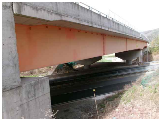
7공구 화남교 (7공구)
