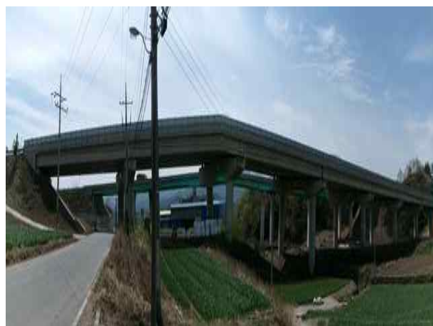
8공구 가천교 (8공구)
