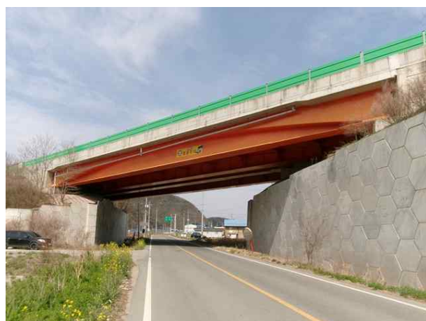
7공구 화남1교 (7공구)
