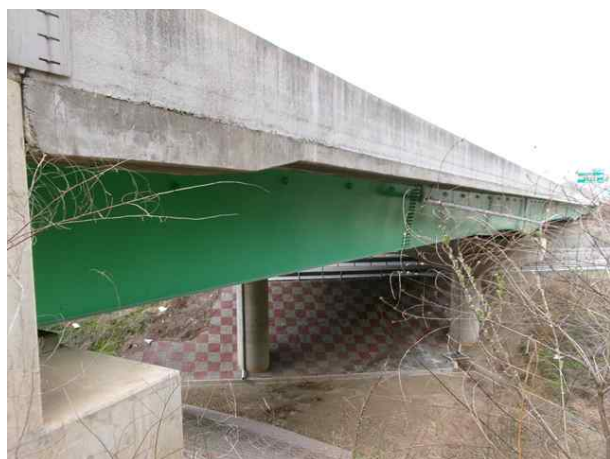
6공구 가호교 (6공구)
