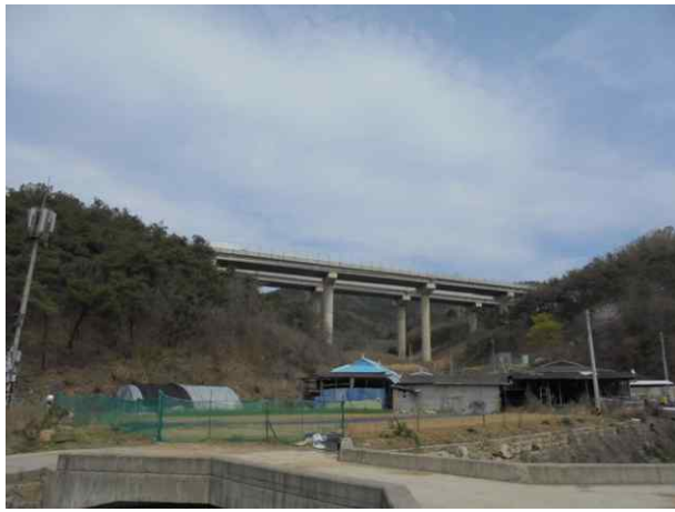
5공구 불당교 (5공구)
