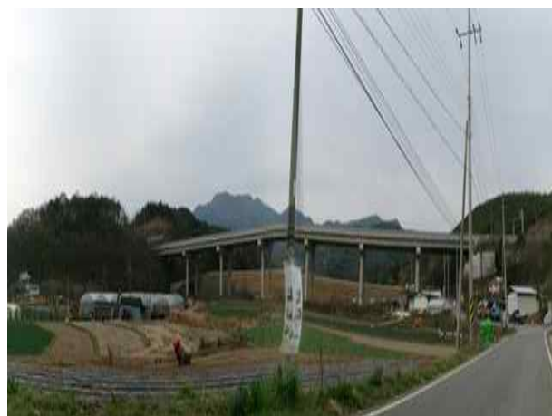
7공구 산성교 (7공구)
