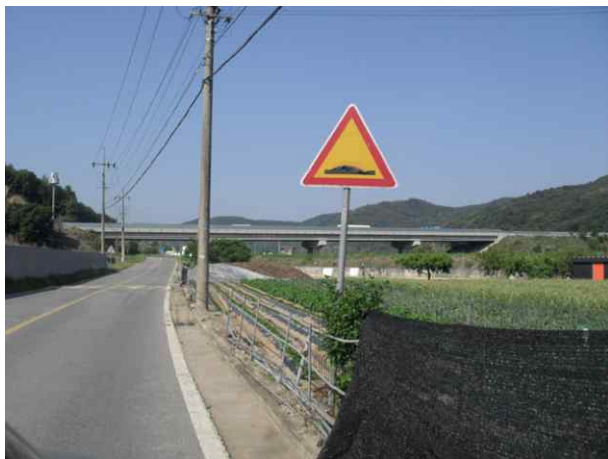
6공구 창기교 (6공구)
