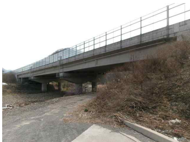
7공구 배골교 (7공구)
