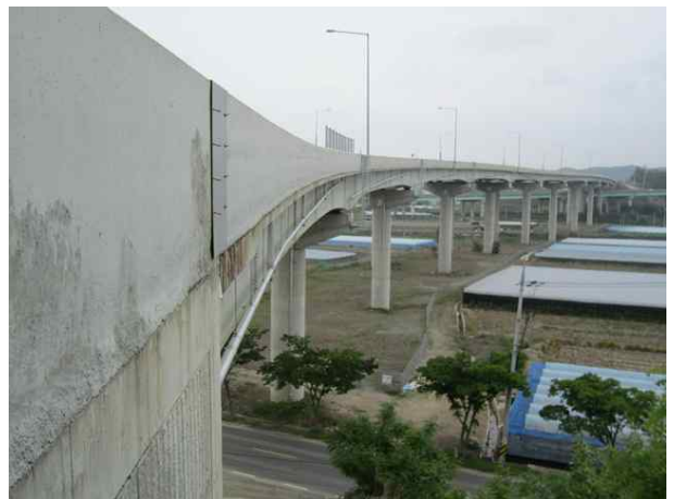
10공구 영천JCT Ramp-B교(10공구)
