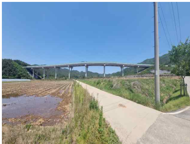
3공구 도개교 (3공구)
