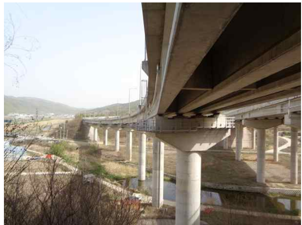
5공구 군위JCT R-C교 (5공구)
