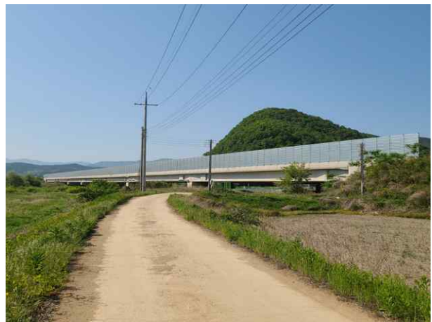
6공구 금매교 (6공구)
