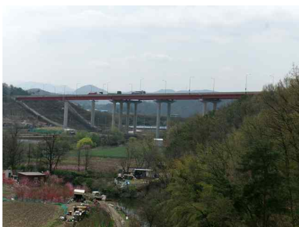
8공구 화산JCT RAMP-A1교(8공구)
