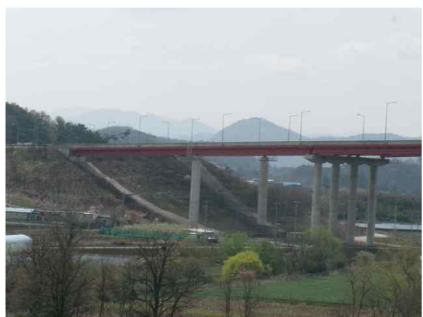
8공구 화산JCT RAMP-H교(8공구)
