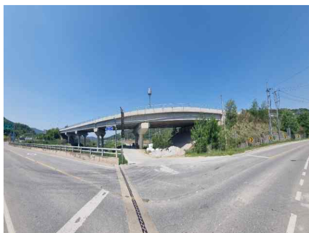
3공구 신계교 (3공구)
